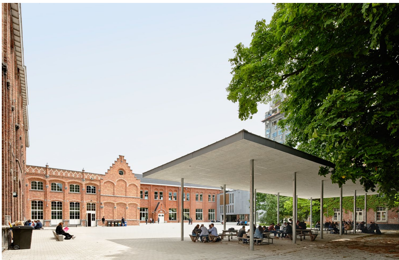
speelplaats derde graad met luifel - fotografie Dennis De Smet
